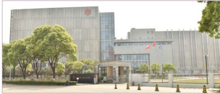
万国数据上海数据中心 Shanghai Data Center
